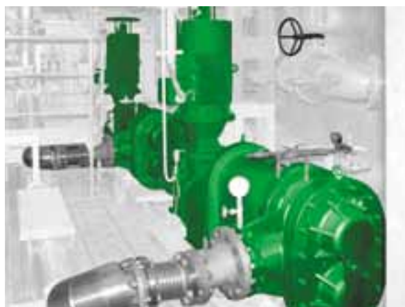
Ротационно-поршневой насос, тип KRHZ 150
